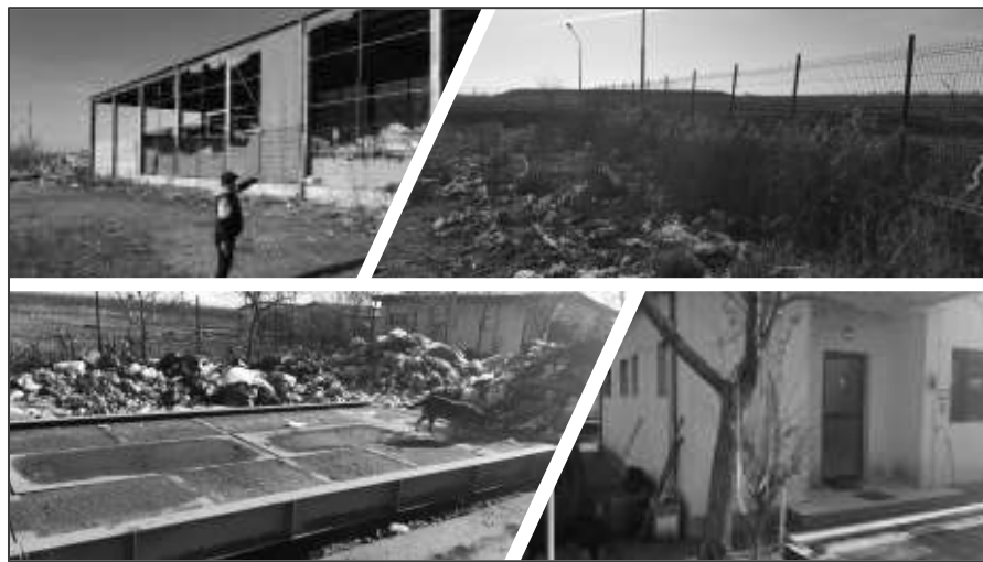
Figura 4-13: Infrastructura stației de sortare Drăgășani
