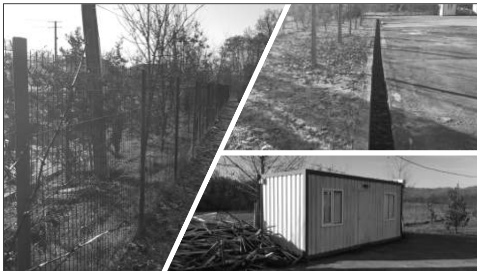
Figura 4-4: Infrastructura stației de transfer Fârtățești
