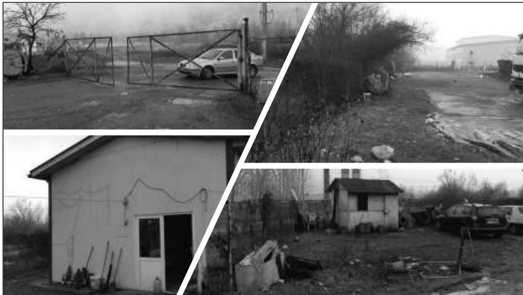
Figura 4-1: Infrastructura stației de transfer Brezoi
