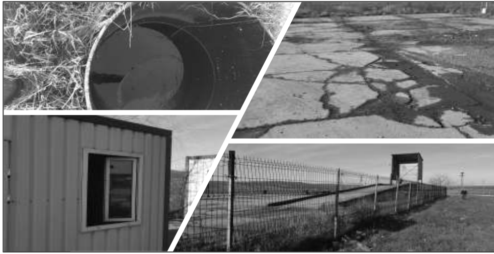
Figura 4-9: Infrastructura stației de transfer Bălcești
