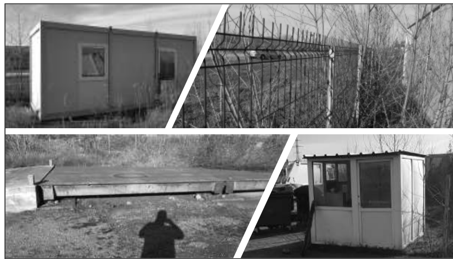
Figura 4-11: Infrastructura stației de transfer Ionești
