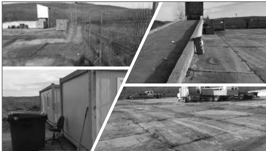
Figura 4-7: Infrastructura stației de transfer Galicea
