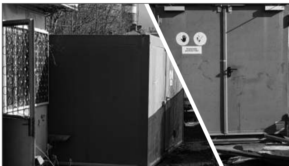
Figura 4-18: Puncte/containere de colectare deșeuri periculoase, Rm. Vâlcea
